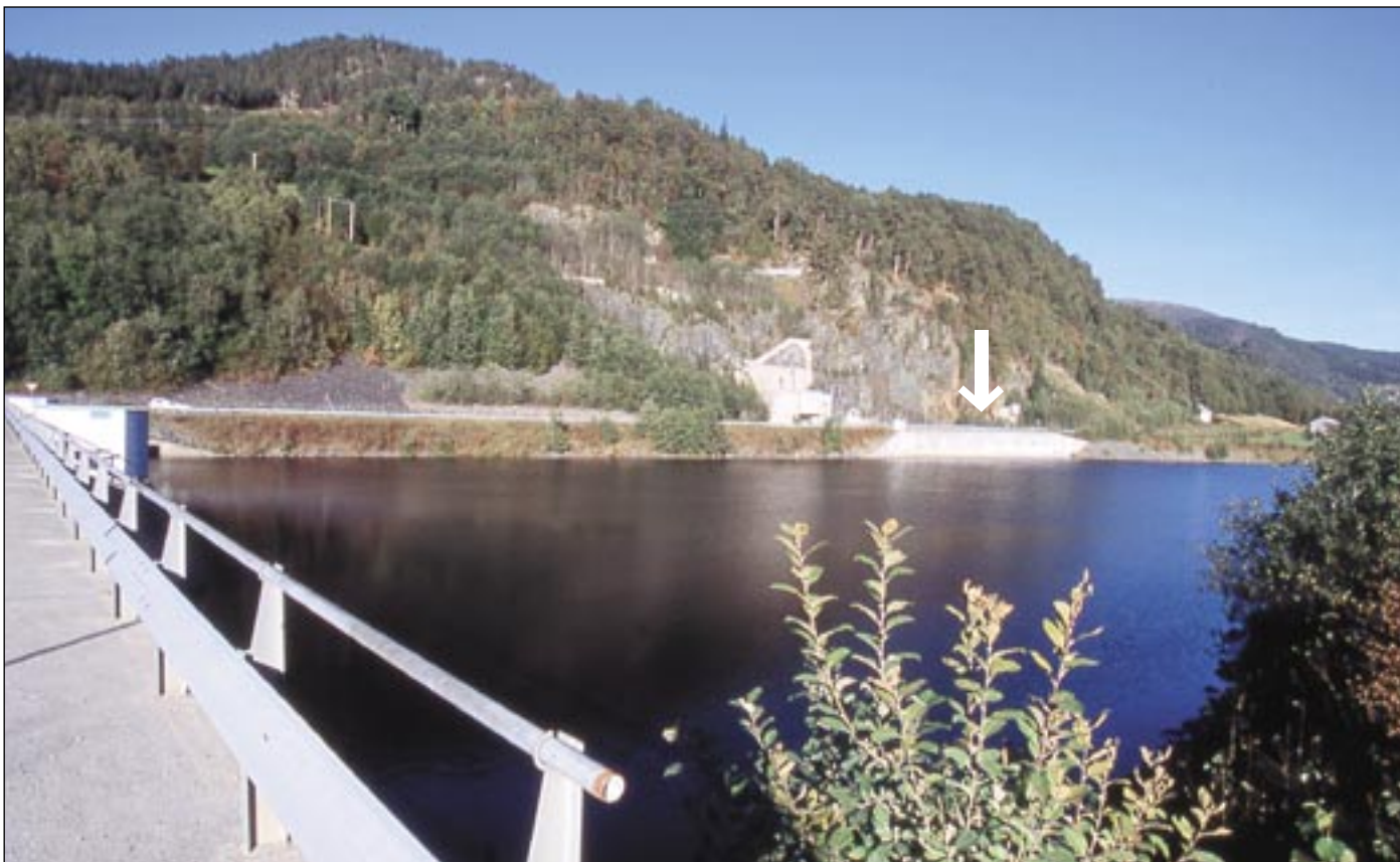
Figur 5.2.2 Inntaket til Svorkmo kraftverk ligger like oppstrøms Bjørsetdammen Foto: Eva B.Thorstad.
