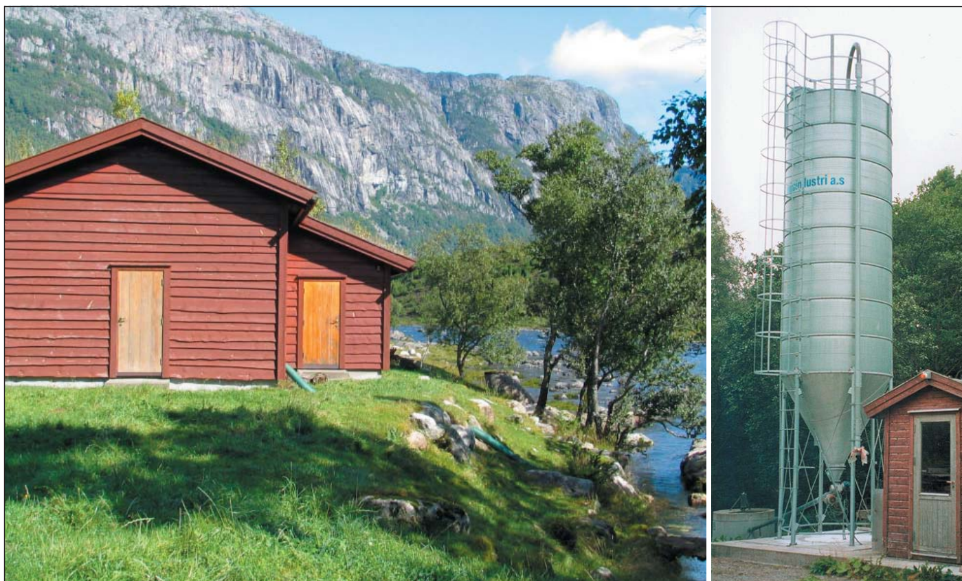
Eksempler på kalkingsanlegg i norske vassdrag. I Ogna (til høyre) startet kalkingen allerede i 1991, da stående kalkdoserere var mest vanlig. I Espedalselva (til venstre) ble kalkingen på utløpet av Espedalsvatnet startet i 1996. Som ved de fleste nyere kalkingsanlegg ble det benyttet en liggende kalkdoserer. I de senere årene er det lagt vekt på estetikken og man har valgt å bygge inn slike kalkdoserere. Foto: Bjørn Mejdel Larsen.
