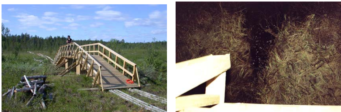
Figur 7. Brua over Hannabekken. Bildet til høyre viser bredden over bekken (0.6 m) på brusedet. Foto: NINA, FIR.
