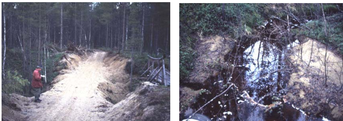
Figur 6. Bildet til venstre er av grusfyllingen over bekkeravine tatt sørøstover. Legg merke til den løse sanden som er i området. Bildet til høyre er tatt fra toppen av grusfyllingen og "oppstrøms" bekken. Foto: NINA.
