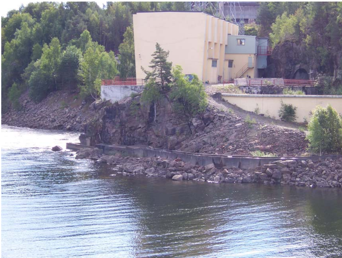
Dagens kraftverksbygg i Skotfoss med utløp til venstre og fisketrapp midt på bildet. Foto: Torbjørn Forseth
