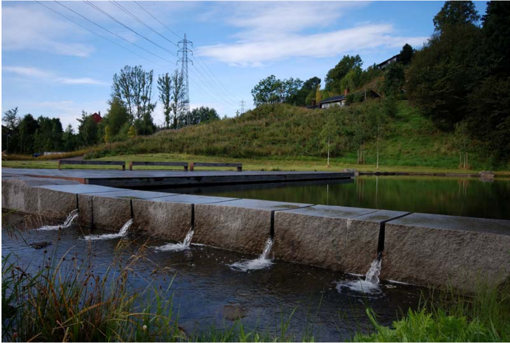
Bilde 2. Fra dammen overføres vannet gjennom et overløp til en kunstig anlagt rensepark (foto: Jon Museth)
