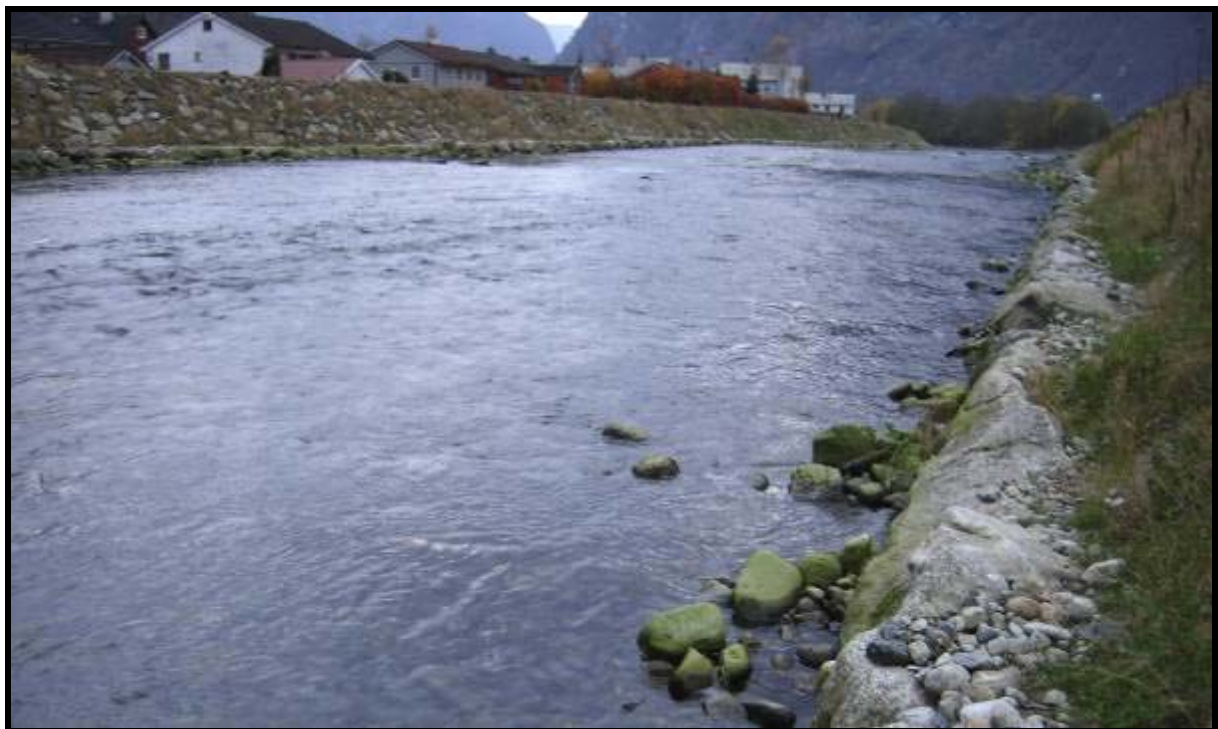
Bilde 1. I nedre deler av Daleelva er et elveparti sterkt påvirket av kanalisering og forbygging.
