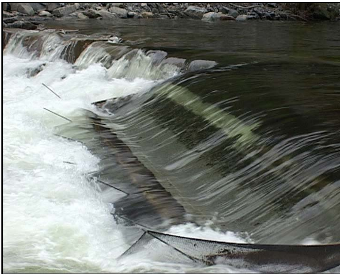
Bilde 2. Fella i Daleelva 20. mai 2007. Rista som skal filtrere ut smolten er oversvømmet og nettet som skal hindre at smolten hopper over rista er presset ned av vannmassene. Det går også noe vann over steinrekka som danner demningen på sidene av selve fella (se forsidebilde). Foto: Anders Lamberg.
