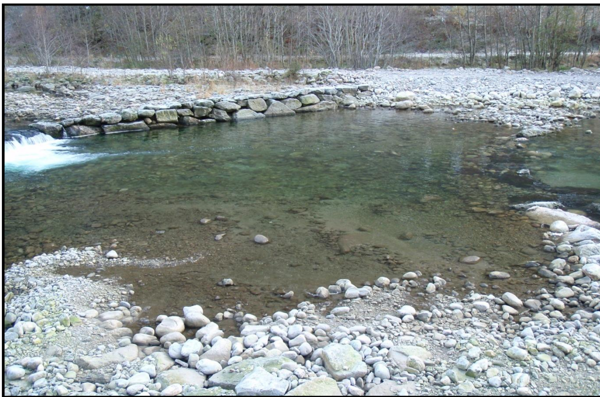
Bilde 13. Hølen nedstrøms denne terskelen fungerer som en sedimentfelle for finere elvemasser. Nedauringen av hølen hadde blitt redusert dersom steinryggen i høyre bildekant hadde blitt fjernet. Fotografi: Gunnbjørn Bremset.
