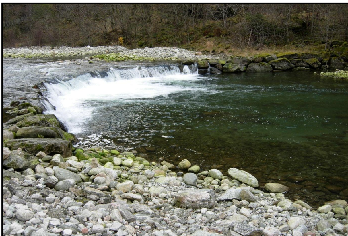
Bilde 3. Tersklene i Daleelva er bygd med såkalt Syvde-utforming, slik som terskelen på bildet (T17 i figur 1 ). Fotografi: Gunnbjørn Bremset.
