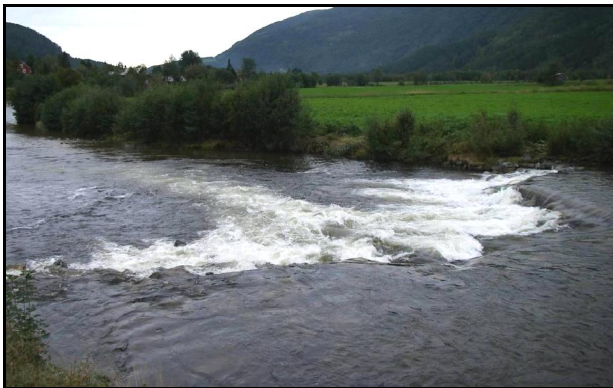
Bilde 12. Denne hølen i Toåa i Surnadal ble dannet etter at det ble laget en syvdeterskel på 1980-tallet. Utformingen har gjort at det i dag er en svært høy produksjon av laksunger i hølen. Foto: Gunnbjørn Bremset.
