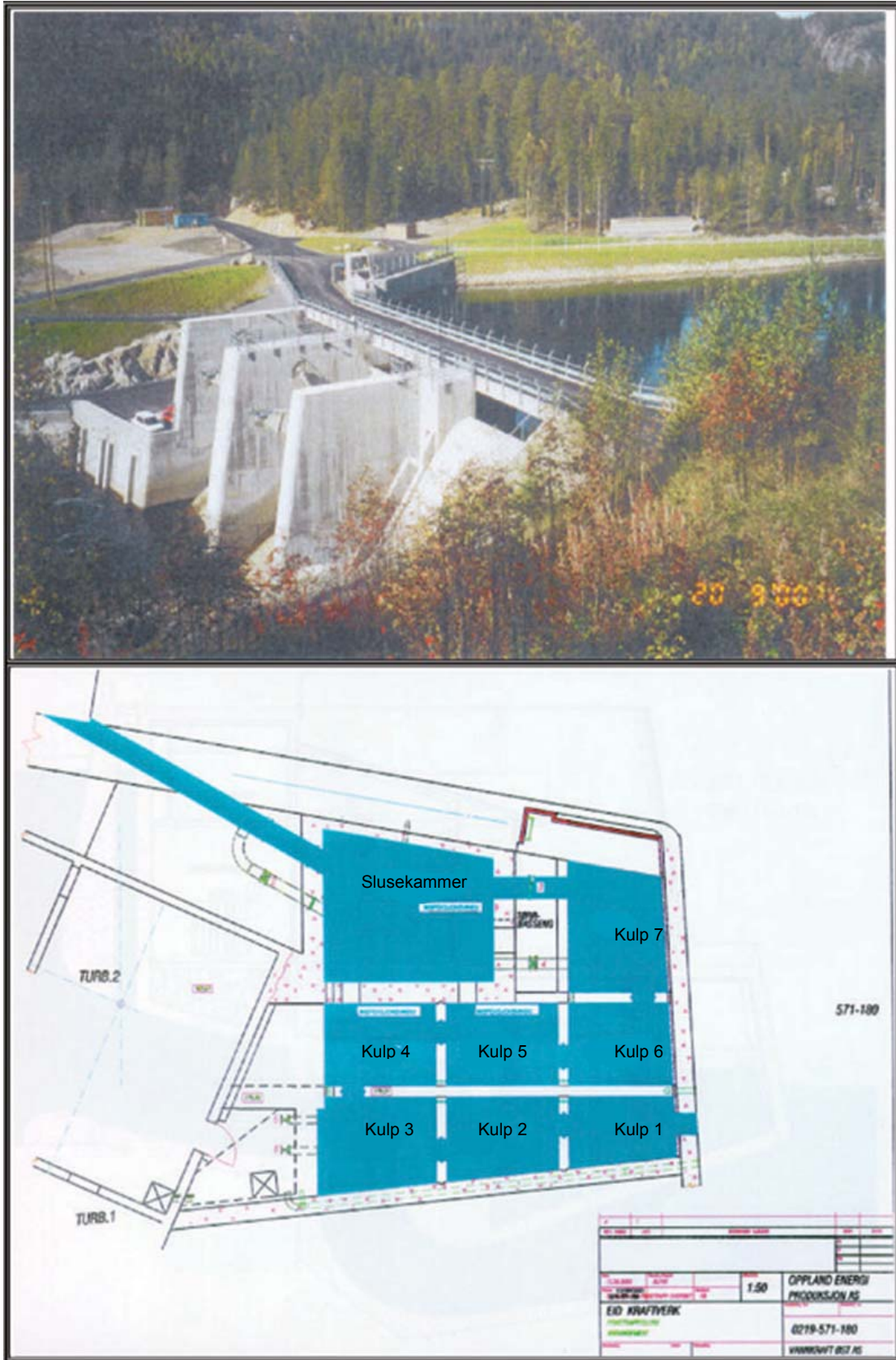
Figur 2.2 Eid kraftverk (foto hentet fra Vannkraft Øst rapport) (øverst). Tverrsnitt av fisketrappa sett ovenfra (nederst).
