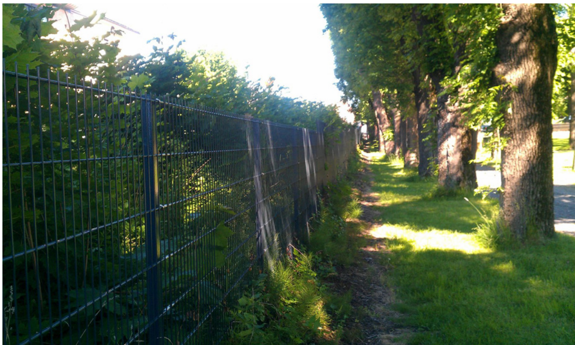
Figur 14. På venstre side av gjerdet går jernbanen. Det er tydelig at det er kraftig oppslag av lønn og andre busker. Bildet er tatt 17. juni 2013. Foto: Magne Flåten
