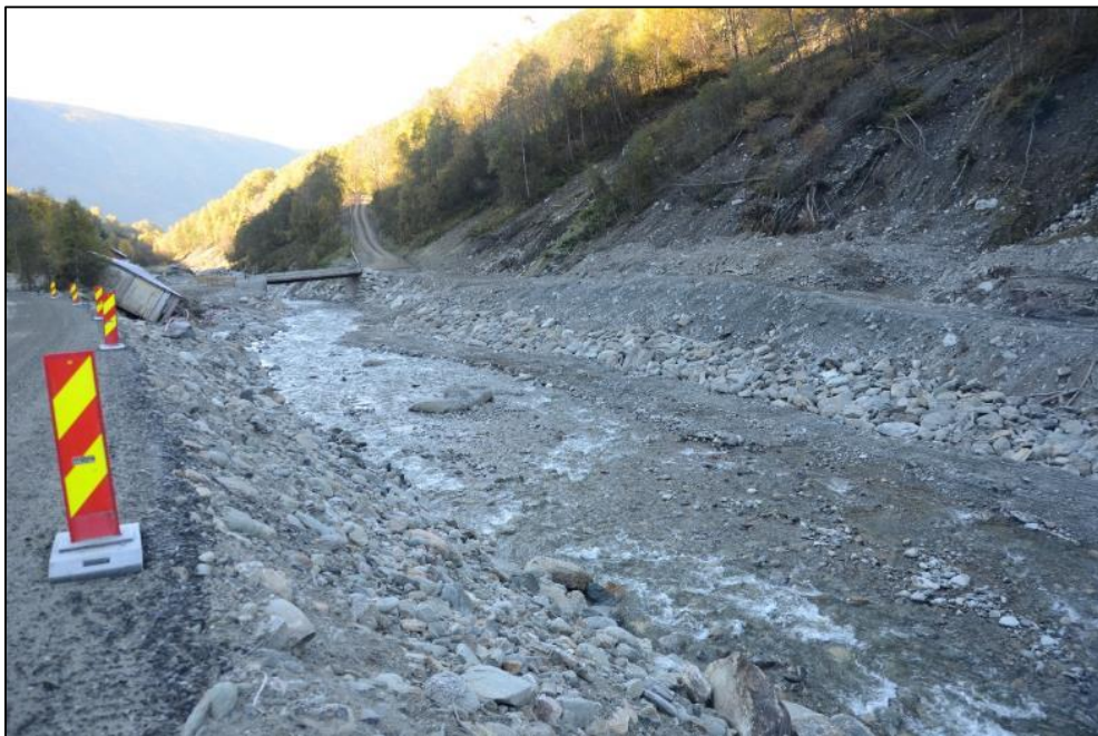
Figur 23. Flomsikringstiltak i Kvam. Område hvor massefangdammer anlegges nedover hovedelvløpet for å begrense elvas eroderende kraft. Foto: P.A. Aarrestad.
