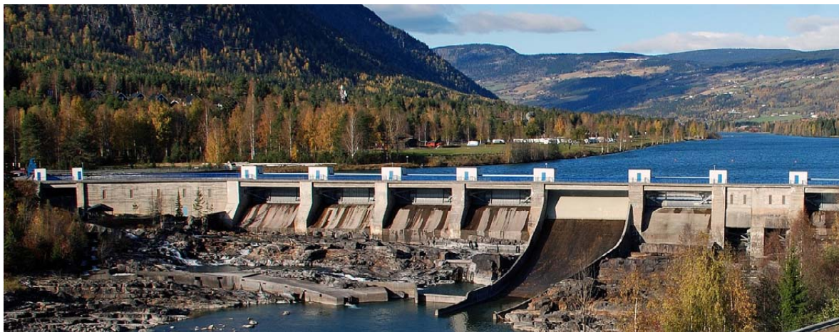
Figur 2.1 Hunderfossen dam med flomluker. Isluka ligger til venstre i bildet (foto: Morten Kraabøl).
