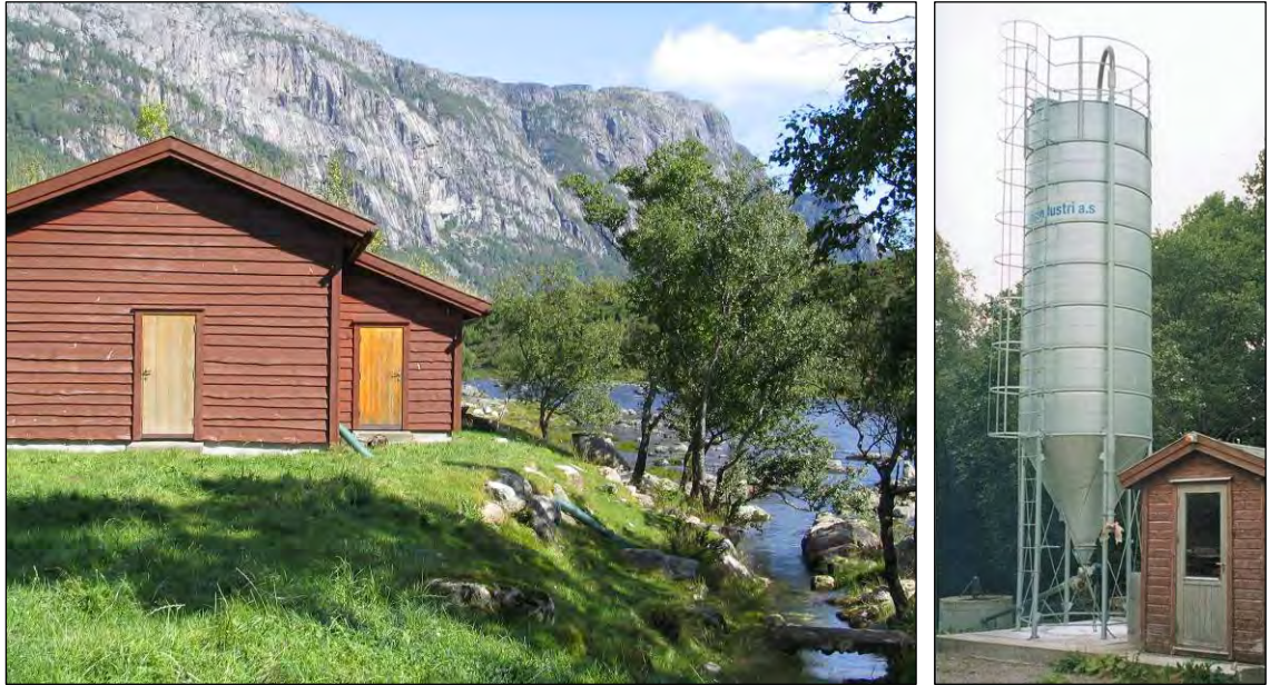
Figur 3.7. Eksempler på kalkingsanlegg i norske vassdrag. I Espedalselva (til venstre) ble kalkingen på utløpet av Espedalsvatnet startet i 1996. Som ved de fleste nyere kalkingsanlegg ble det benyttet en liggende kalkdoserer som er bygget inn i en driftsbygning. I Ognå (til høyre) ble kalkingen startet allerede i 1991, da stående kalkdoserere var det mest vanlige. Foto: Bjørn Mejdell Larsen.
