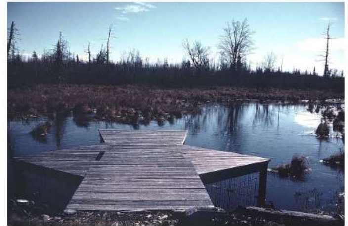
Figur 11.6 Ulike for-dammer. Merk robust konstruksjon (noe som utvilsomt lønner seg) samt tilpasning av formen til formen på bekken. Det siste bildet viser en konstruksjon (som ligger i et naturreservat) utstyrt med plattform som å gjør den mer attraktiv, samtidig som den kan tjene som utsiktspunkt for besøkende. Foto: S Lisle / S. Tippie
