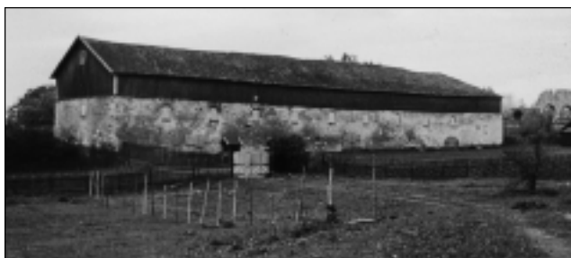
Storhamarlåvens fjøsfløy sett fra nord.
