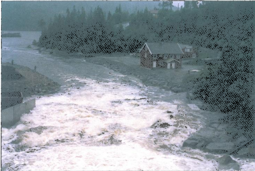
Opløyelva ved høy vannføring. Fangstfella til høyre, turbin utløpet fra kraftstasjonen til venstre på bildet.
