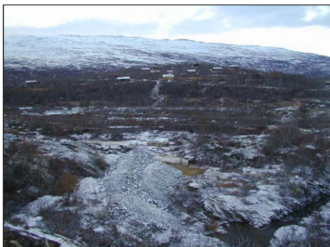
Midlertidig lagringsområde for tunnelmasser under anleggsperioden.
