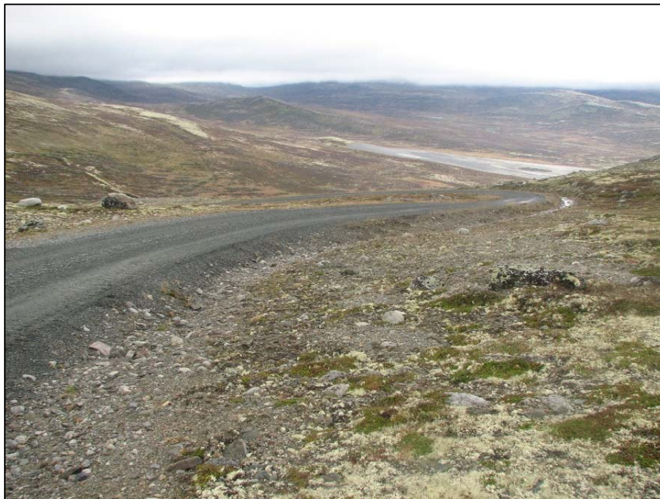
Figur 19. Terrenget etter fjerning av veg på Haugbergmyrene, september 2010. Foto: D. Hagen.
