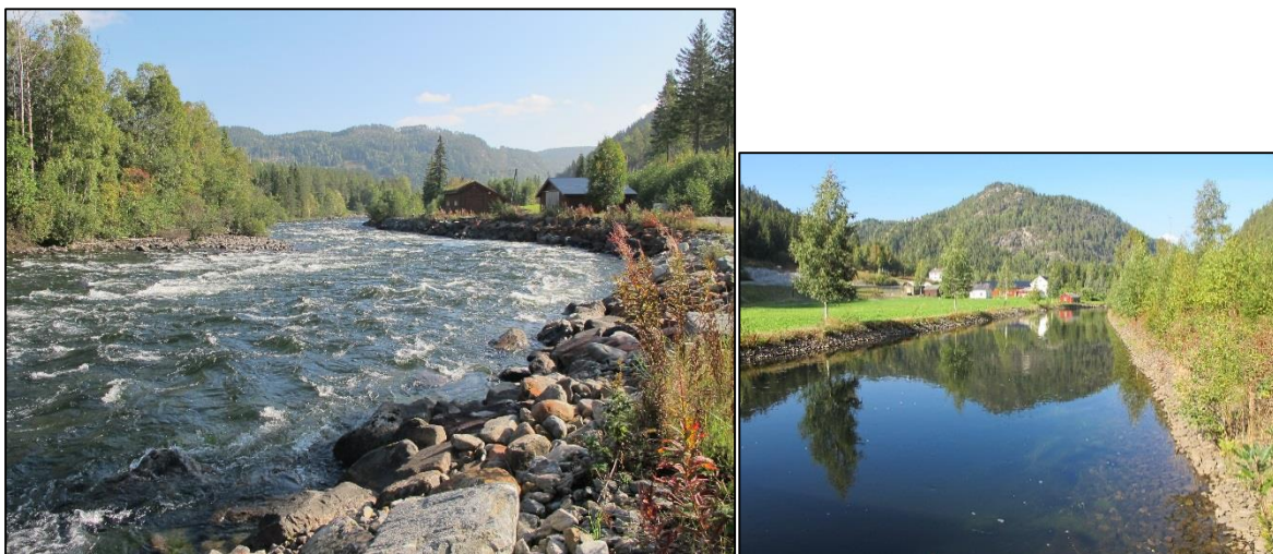
Koparvike minikraftverk har en inntakskanal som leder vann fra Begna til selve kraftverket. I forbindelse med utbyggingen ble det laget en lang forbygging ut mot Begna. Foto: Bjørn Mejdell Larsen.
