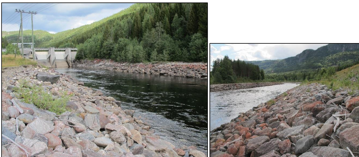
Eid kraftverk sto ferdig i 2000. Nedenfor demningen er elveløpet kanalisert på en ca. 1,3 km lang strekning. Foto: Bjørn Mejdell Larsen.
