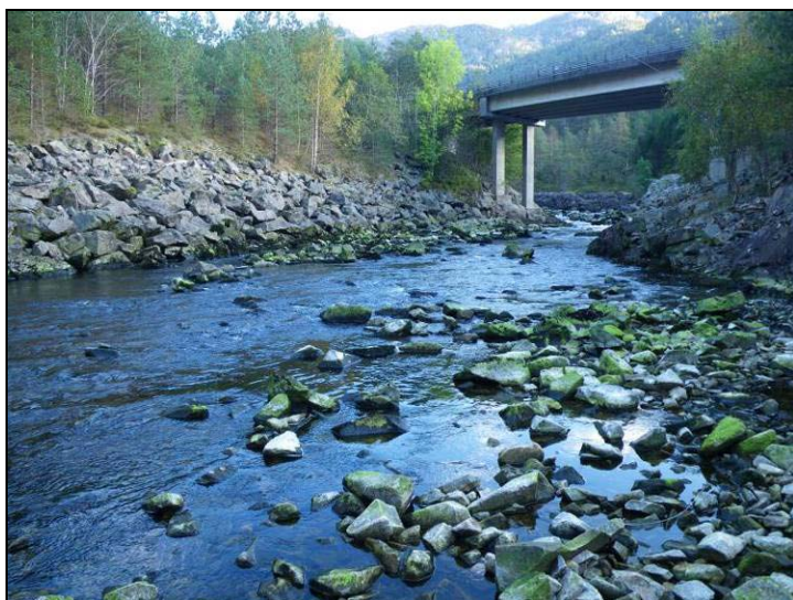
Fjæraelva (stasjon 5.1) mellom Rullestadvatnet og Håfossen har avgrensede leveområder for fisk på grunn av vandringshindre både ovenfor og nedenfor strekningen. Foto: Bjørn Mejdell Larsen.
