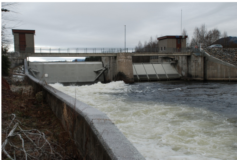
Bilde 7 Eksempel på ugunstig lukemanøvrering ved Storsjødammen. Vannføringen slippes på motsatt side av fisketrappen, og oppvandrende fisk får vanskeligheter med å lokalisere fiskeinngangen i trappa. Foto; M. Kraabøl.
