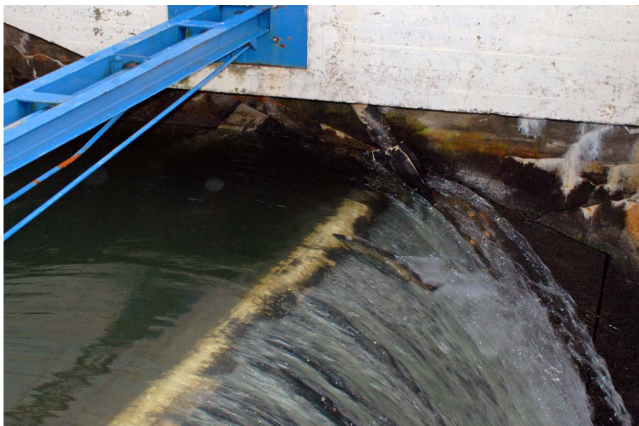
Nedvandring av utgytt voksen ørret over flomluke ved Hunderfossen kraftverk. Flomluker med lav fallhøyde er meget gunstige vandringsveier for fisk forbi kraftverk (Foto: M. Kraabøl).
