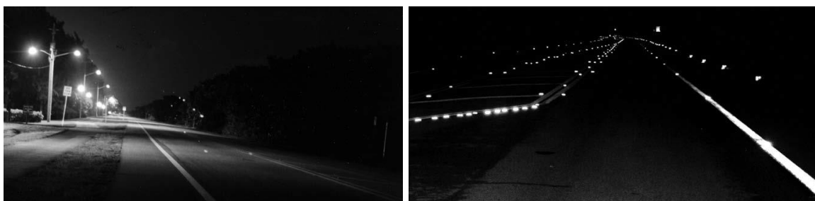
Figur 5.9. Gatelys langs en kystvei i Florida, langs en strand hvor havskilpadder legger egg. Stranda er til høyre for veien, men er ikke synlig på bildene. Bildet t.v. viser en natt med de tradisjonelle gatelampene påslått, på bildet t.h. er disse avslått og innebygde lys er påslått. Gatelysene er synlige fra stranda, de andre er det ikke (fra Rich & Longcore 2006).
